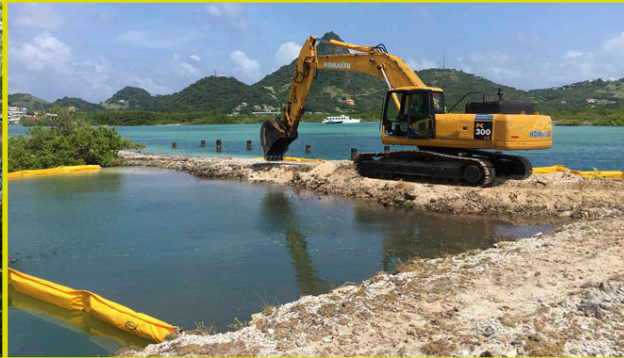
Figura 94: Excavación del muelle en la laguna Ashton. Foto: SusGren
