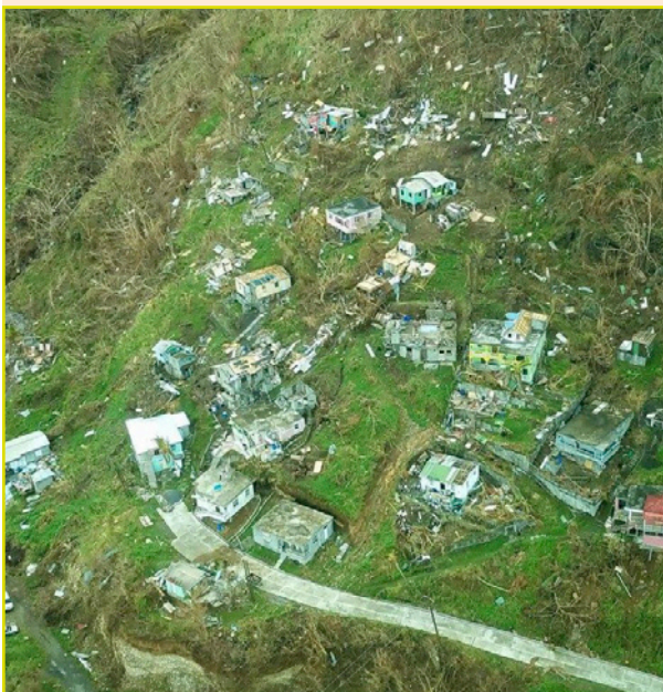
Figura 11: Daños en Dominica tras el huracán María en 2017. Foto: Andrew MacCalla Direct Relief
