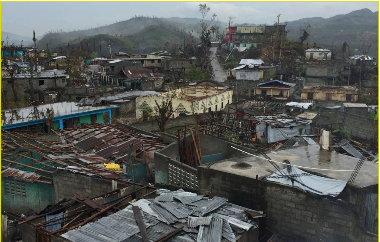
Figura 10: Daños en la ciudad de Moron, Haití, tras el huracán Matthew. Foto: Avi Hakim, CDC (Flickr) [CC BY 2.0 ( http://creativecommons.org/licenses/by/2.0/ )], a través de Wikimedia Commons
